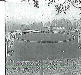
Vista de la planta de purines.
